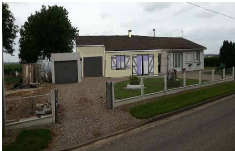
Extension d'habitation type phénix située à la Villers Campsart (80)
